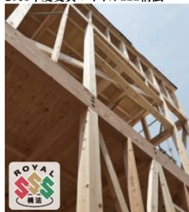
暮らしの価値を創る十字型木構造柱 X-column構法
